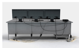
Herkömmliche Lösung Unordentliche Verkabelung
