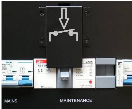
Abb. 6-1 Korrekt aufgesetzte Sicherheitsabdeckung des manuellen Bypasses (beispielhafte Darstellung).
