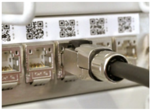
Vor der Prüfung - Scannen des Etiketts mit dem WireXpert MP
